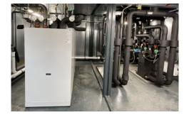
Leistung: 2 x 150 kW Brennstoff: Wärmepumpe
